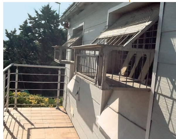
Une partie des installations
